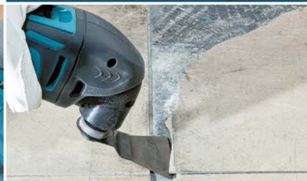
Удаление напольной плитки
