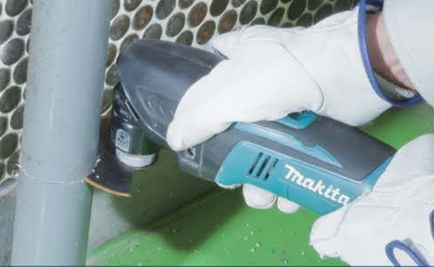
Резка труб из ПВХ и стеклопластика
