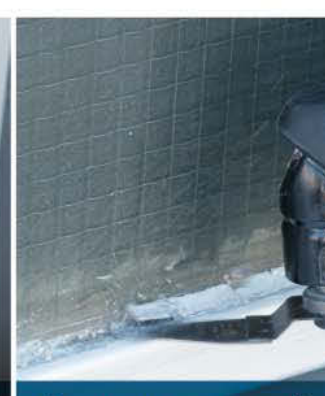
Удаление оконной замазки
