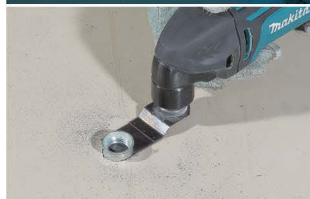
Резка металлических труб заподлицо
