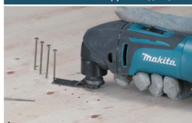
Резка гвоздей заподлицо
