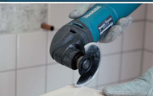
Резка керамической плитки
