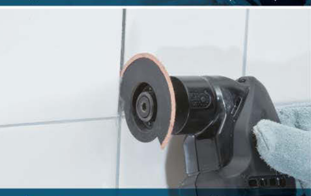
Очистка швов между плиткой
