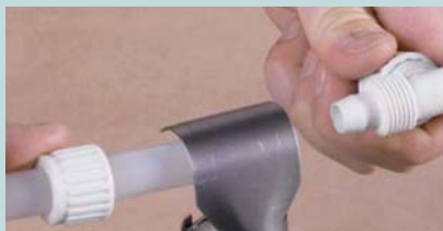
Монтаж пластиковых труб
